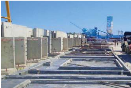
CÔNG TÁC LẮP VÁN KHUÔN CẤU KIỆN VÁCH (Install the)
