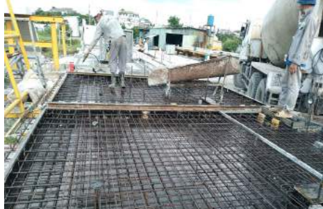
CÔNG TÁC ĐẶT CỐT THÉP CẤU KIỆN VÁCH (Place Rebar)
