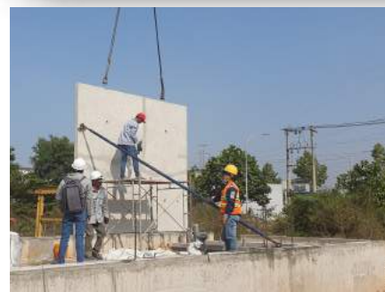
CÔNG TÁC LẮP CHÉP CẤU KIỆN VÁCH TẠI CÔNG TRÌNH (Assembly at site)
